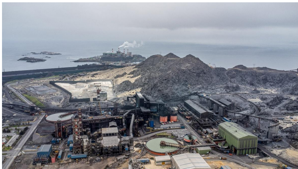
Figura 26. Planta de pelotas de minério de ferro da CMP e complexo termelétrico da Guacolda ao fundo
